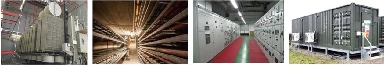
Abbildung 10: Beispiele für andere Bereiche, die sich durch die gleiche Art der BBA absichern lassen. Von links nach rechts: Transformatoren, Kabelkanäle, Schaltanlagen, stationäre Energiespeicher. Fotos: FOGTEC.
